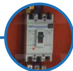
Breaker en caja moldeada
